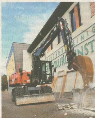
Der Bagger kommt zum Einsatz. Im Innenbereich laufen bereits Arbeiten.
