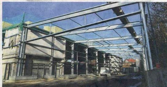
Der Anlieferbereich des neuen Glaslagers. Ein Dach soll vor Regen schützen, eine Wand zum Schomburgk-Park den Geräuschpegel im Rahmen halten.
