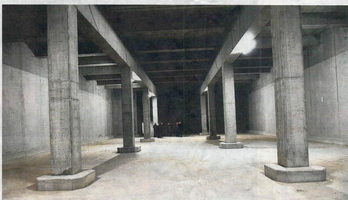
Imposante Säulenhalle. Unterm neuen Glaslager der Rotkäppchen-Sektellerei wird ein Reifekeller für Flaschengärsekte gebaut.
